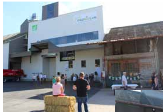
Silo de Vézelize : à droite, on conserve, à gauche on innove.
